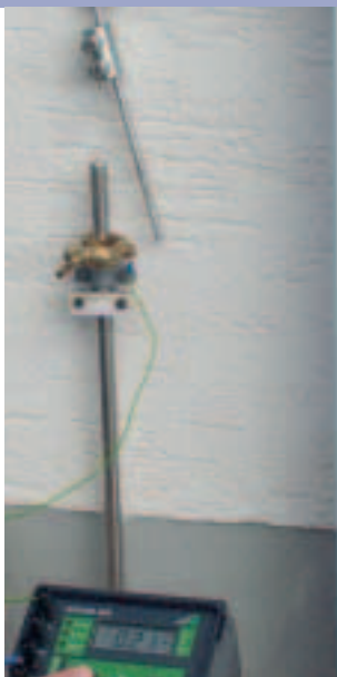
Измерение сопротивления заземления
